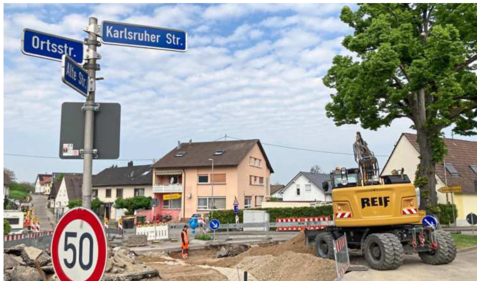
Kein Durchkommen: Die Sanierungsarbeiten sorgen dafür, dass Friedhof, Kindergarten und Eichelberghalle nur über Waldprechtsweiler zu erreichen sind. Foto: Swantje Huse
